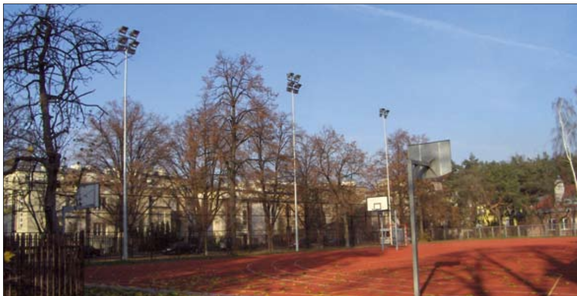
Oświetlenie typu Horus zamontowane na boisku przy ul. Żuga w Warszawie
